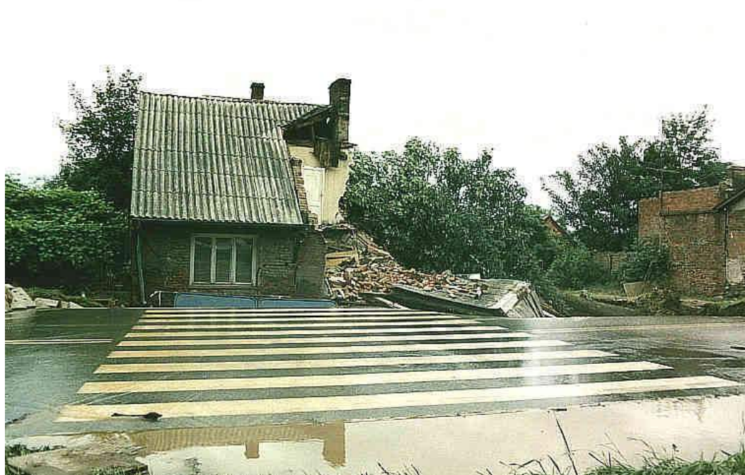
Rys. 11.4 Uszkodzony budynek przez powódź w Gdańsku w 2001 roku. [12]
