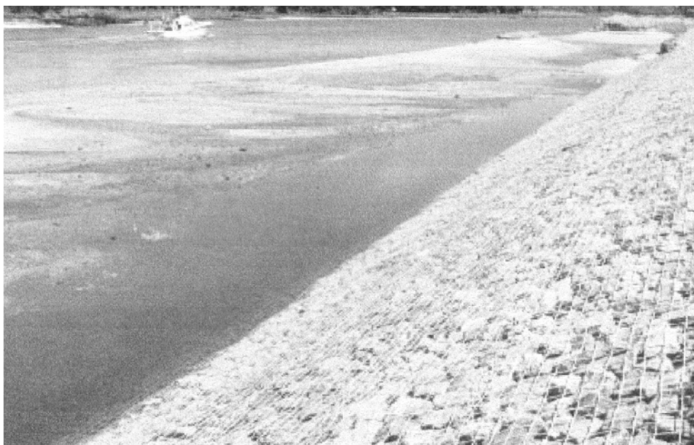
Rys. 10.12. Skarpa rzeki umocniona gabionami.
