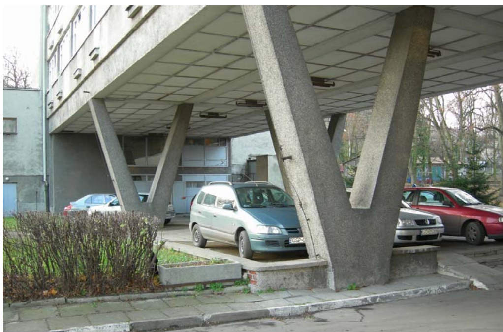
Rys. 11.8 Budynek użyteczności publicznej na słupach.
