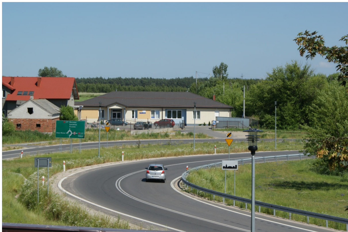
Fot. Budynek Ośrodka Zdrowia w Załuskach
