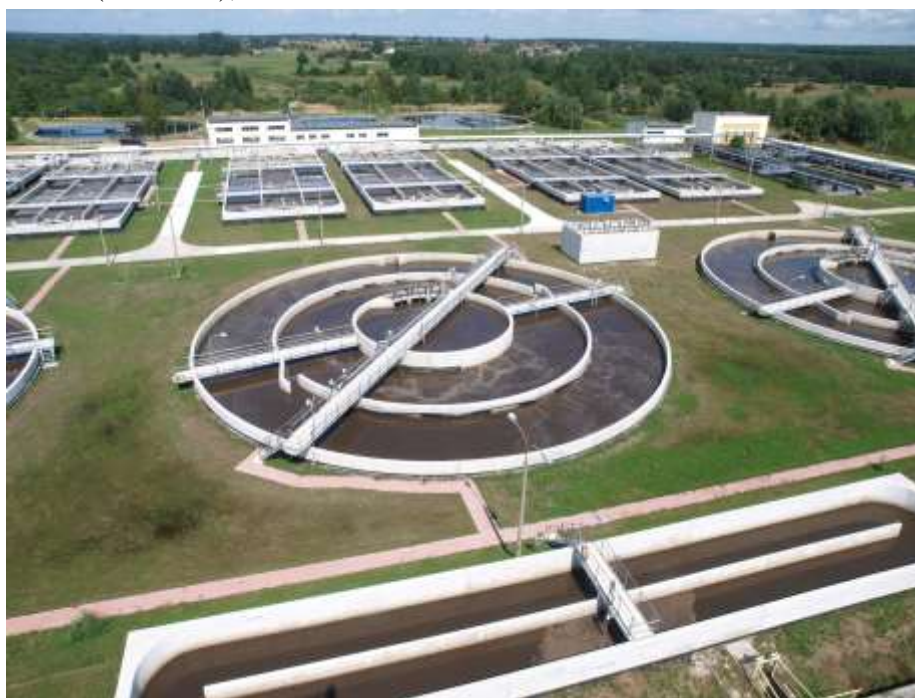
Fot. 3.7. Miejska oczyszczalnia ścieków w Radomiu (źródło: Wodociągi Miejskie w Radomiu Sp. z o.o.)
