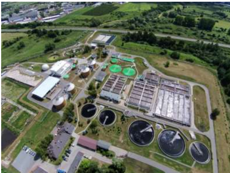
Fot. 3.5. Miejska Oczyszczalnia w Siedlcach po rozbudowie i modernizacji w 2014 roku (zdjęcie przekazane przez PWiK Sp. z o.o. w Siedlcach)
