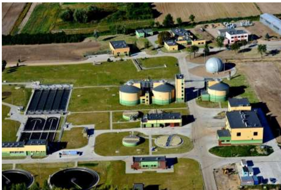
Fot. 3.6. Miejska Oczyszczalnia Ścieków w miejscowości Maszewo eksploatowana przez Wodociągi Płockie Sp. z o.o. (źródło: Dariusz Bógdała „Wodociągi Płockie” Sp. z o.o.)
