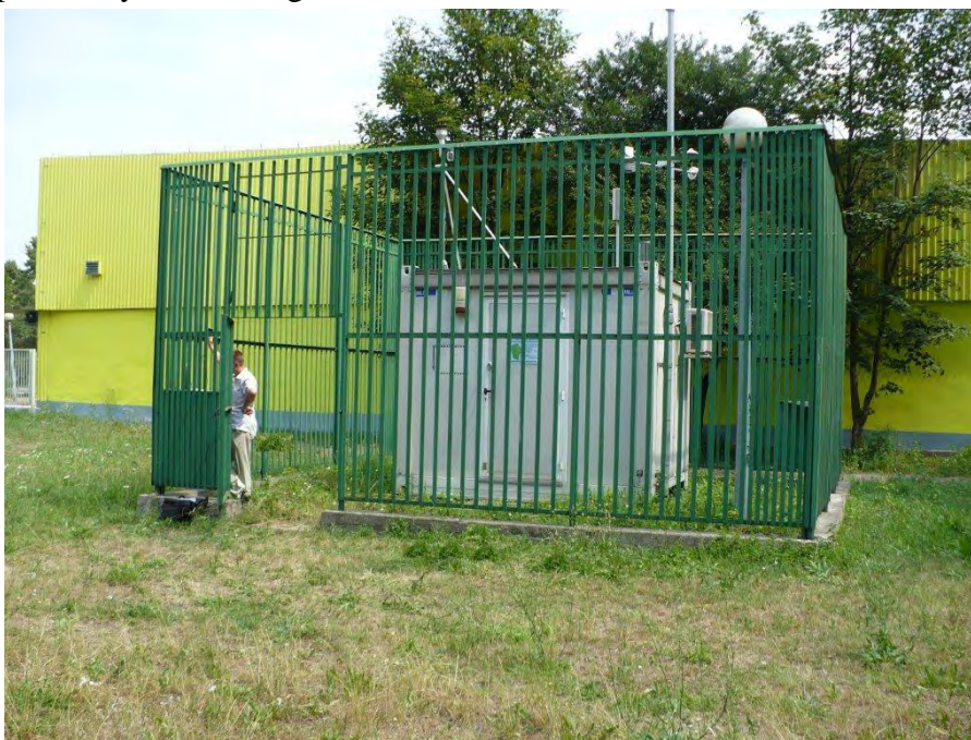
Fot. 2.1. Stacja monitoringu powietrza w Żyrardowie (źródło: WIOŚ)
