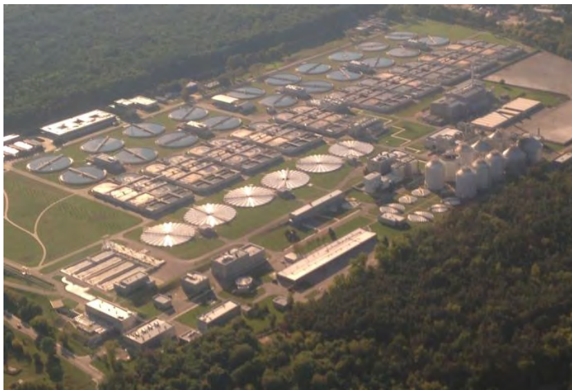
Fot. 3.2. Oczyszczalnia Ścieków „Czajka” w Warszawie (źródło: Adam Chwieduk, MPWiK w m.st. Warszawie S.A.)
