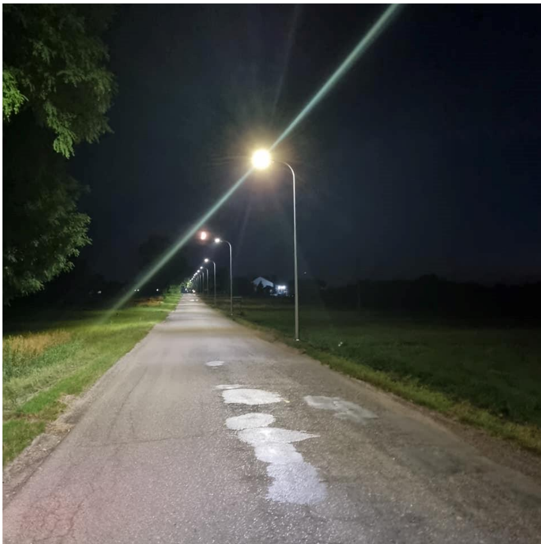
Fot. Zamontowane lampy przy drodze powiatowej w miejscowości Zdunowo
