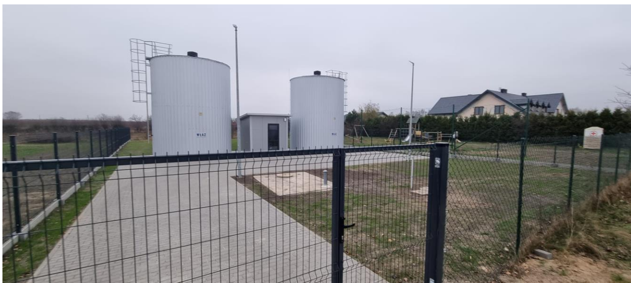
Fot. Przepompownia w Nowych Olszynch
