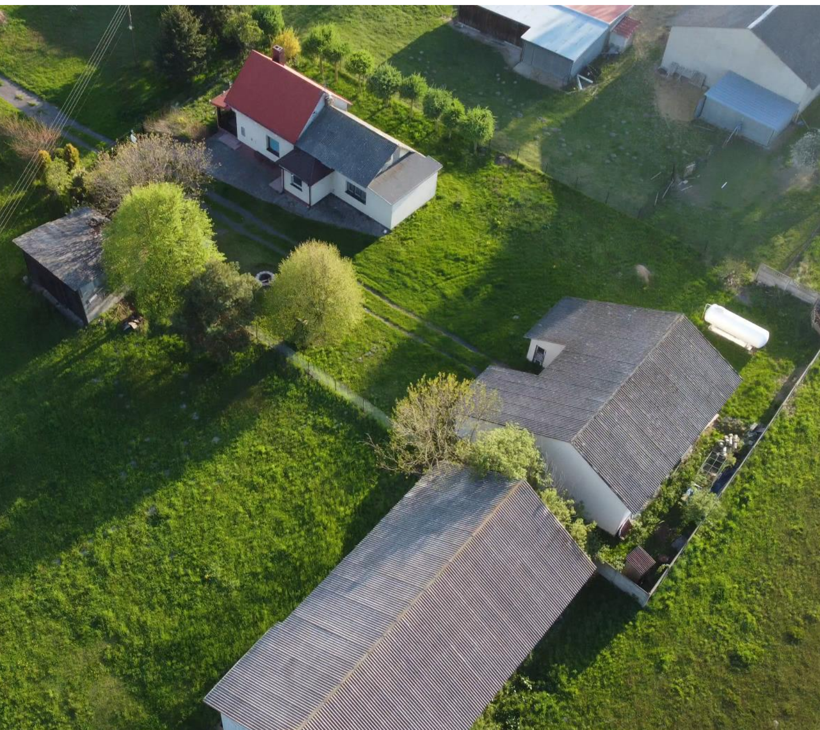
Fot. 1. Wykorzystanie wyrobów azbestowych jako pokrycia dachowe.
