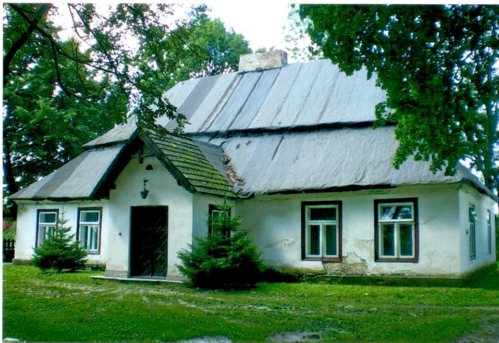
Widok od strony północno - wschodniej
