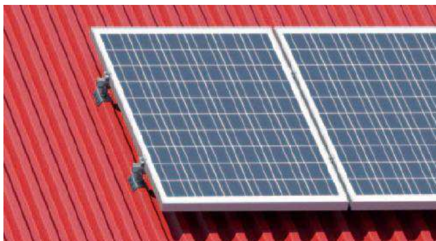
Fotografia. Montaż paneli PV pionowy na dachu krytym blachą trapezową
