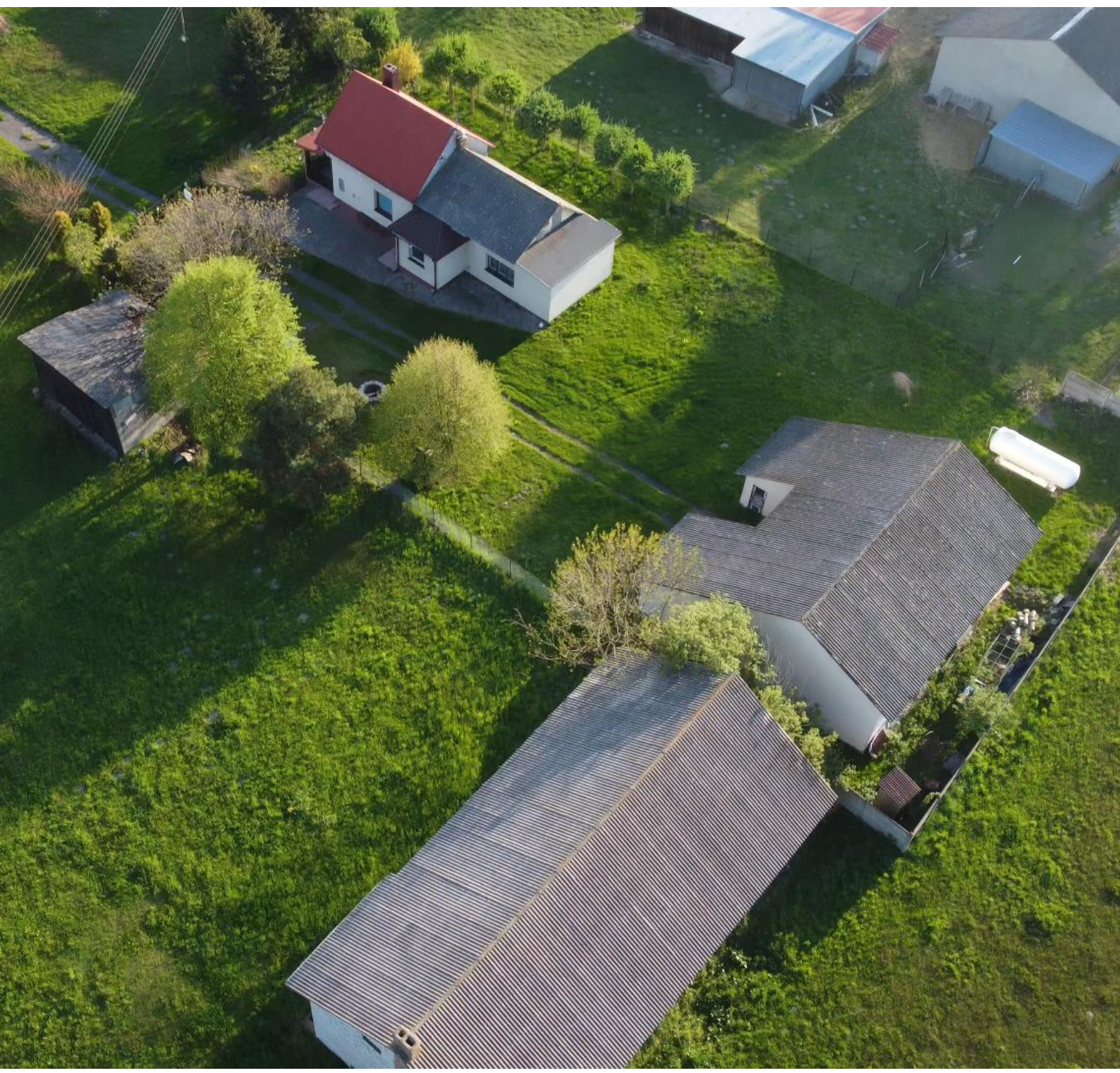
Fot. 1. Wykorzystanie wyrobów azbestowych jako pokrycia dachowe.
